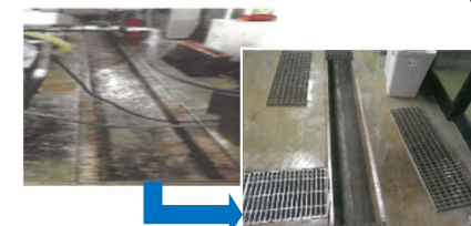
EU・東アジア等向け調味料製造施設における汚水滞留防止のための排水溝改修
