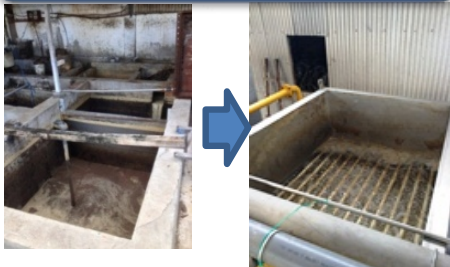
既存の排水処理槽
