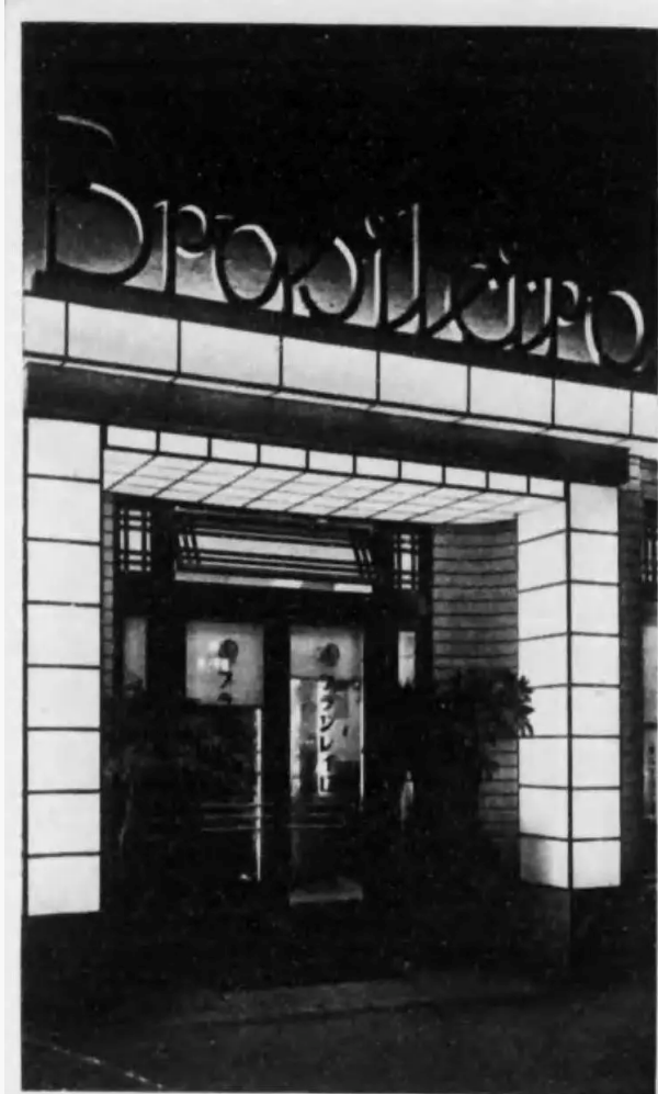
ブラジレイロ 京都市河原町西端下 天井 20W×10 高さ 2.45m 柱 各 12W×14 長さ 12.12m 庇 60W×22 屋上開採照明 庇欄間の一部を を除去するもの
