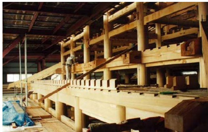
木工事の状況
