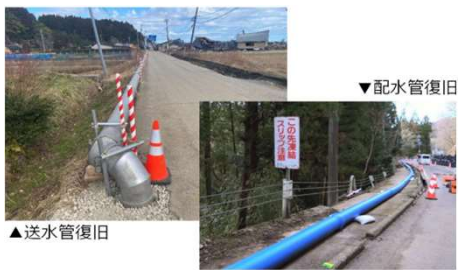
仮設配管を活用した水道の応急復旧
