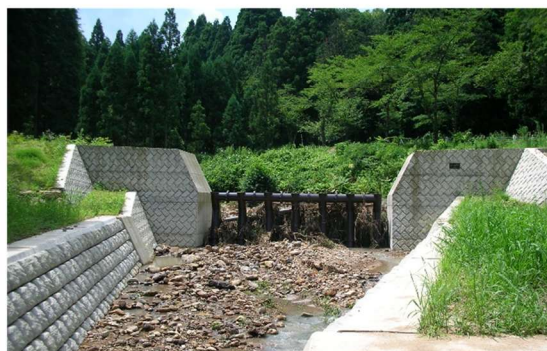
小矢部川水系セド谷堰堤（南砺市才川七地内）
