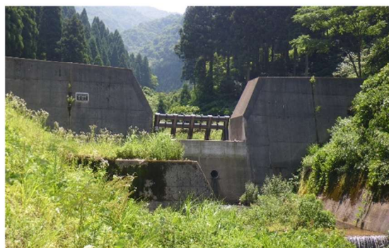
小矢部川水系小谷谷川流木止工（南砺市東西原地内）
