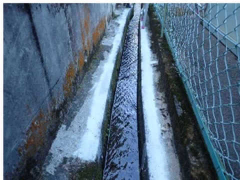
水路引き継ぎに係る除草・水路補修
