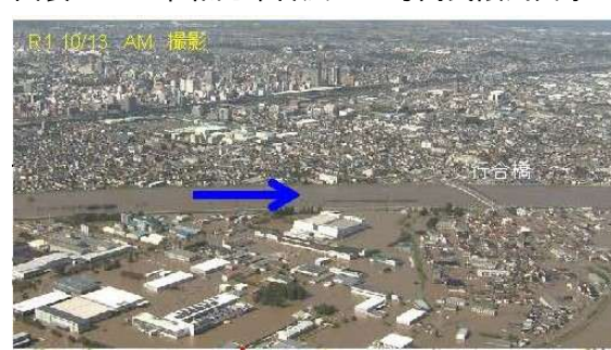
図表 1.3 令和元年台風19号阿武隈川出水
