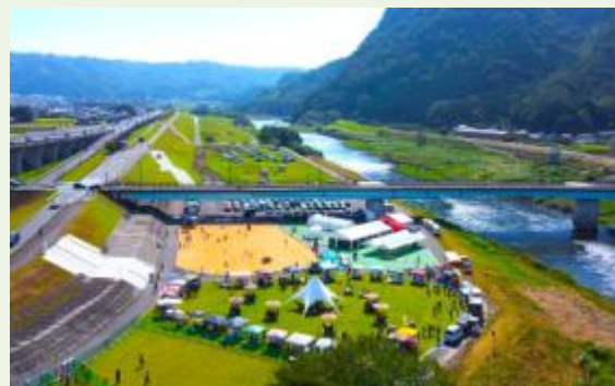
写真8 「かわまちづくり」支援制度により整備された交流拠点（静岡県伊豆の国市）
