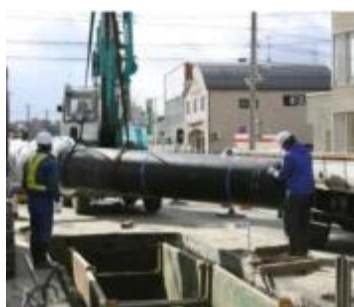
耐震管の布設工事
