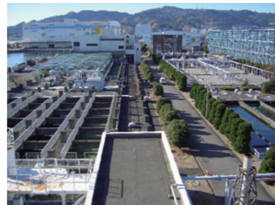
浄化センター
