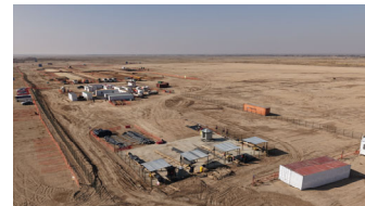
サマルカンド太陽光発電所・蓄電池設備 建設予定地 (出典：住友商事(株))
