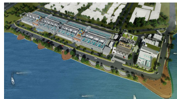
ジャカルタ下水道整備事業 (出典：大林組)
