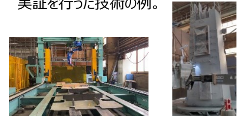
溶接ロボット
