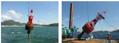
▲灯浮標の定期交換
