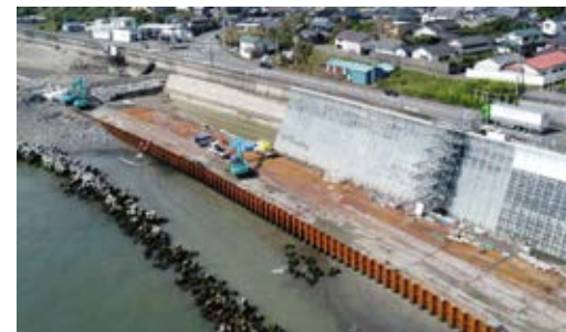
津波対策が進む現地状況(静岡県牧之原市)
