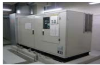
▲非常用電源設備の換装
