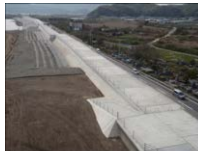
耐震対策が完了した海岸堤防(高知県高知市)
