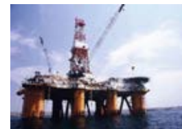
海上大型掘削装置
