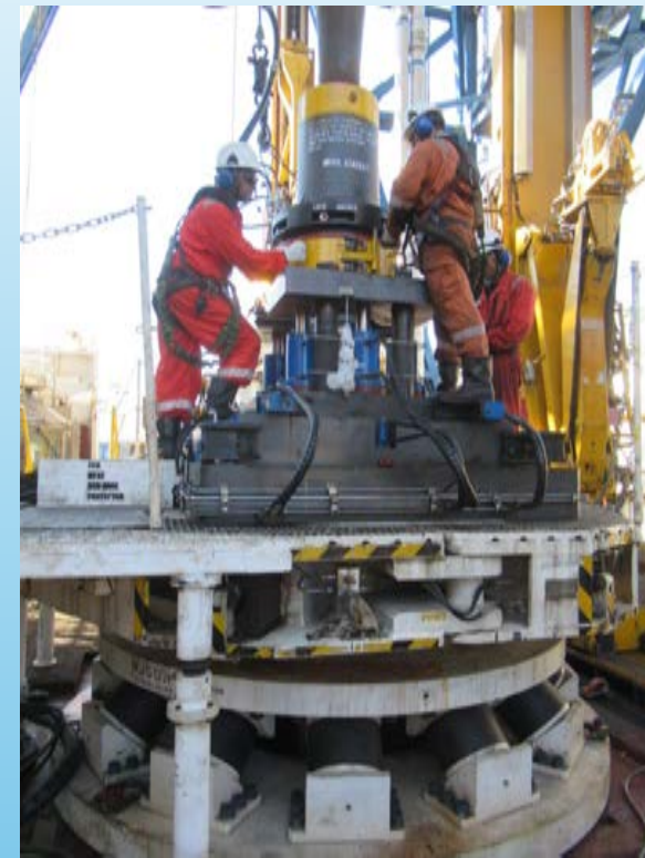
揚泥管接続機器作動確認
