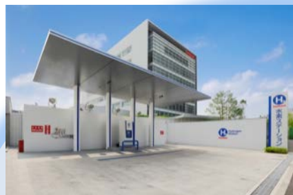
＜水素ステーション＞
