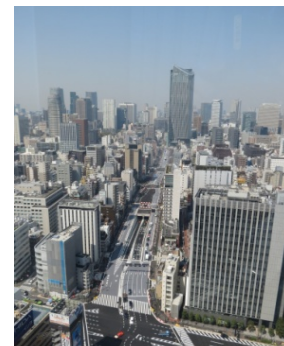
環状2号線の整備
