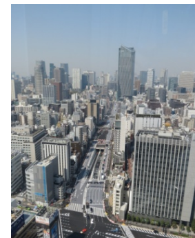
環状2号線の整備
