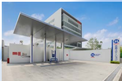
＜水素ステーション＞
