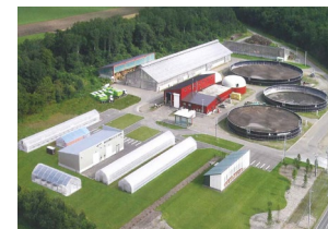
バイオガス発電・熱利用
