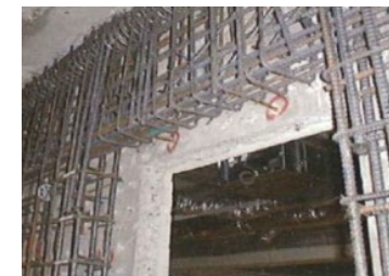
下水処理場の耐震化
