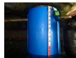
鋼管杭の被覆防食の更新
