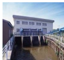
排水機場の整備
