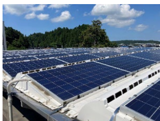
令和6年能登半島地震で 機能発揮した太陽光発電 設備(珠洲市役所)
