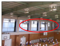
体育館への空調設置
