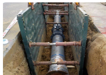
水道基幹管路の耐震化
