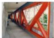
鉄骨ブレースによる壁の補強
