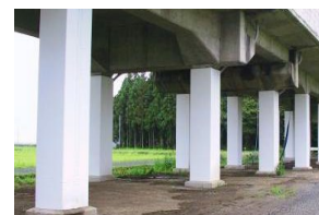
鋼板巻きによる高架橋の耐震補強
