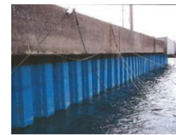
岸壁、鋼製矢板の腐食対策
