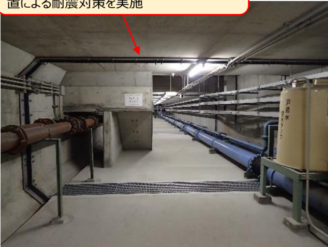
終末処理場の耐震対策状況
