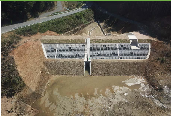
施工後（緊急放流施設の新設。底樋の改修φ300→φ800）
