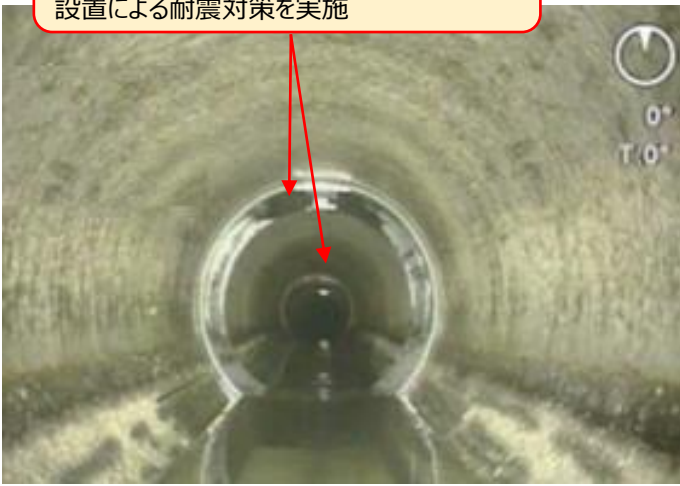
幹線管渠の耐震対策状況
