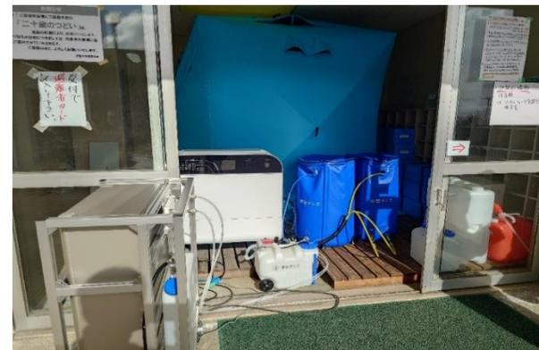
小規模分散型水循環システム
