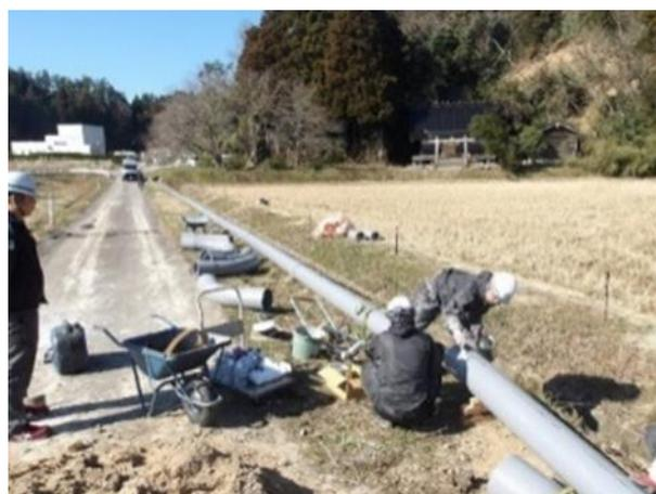
区域の下水を集約し処理場へ送る圧送管の被災（珠洲市熊谷ポンプ場からの圧送管）
