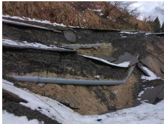
水道水を配水する拠点となる配水池へ送る送水管の被災（輪島市送水管）
