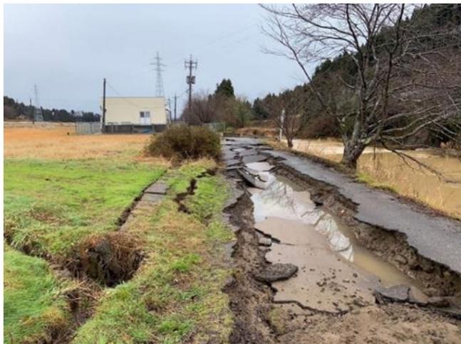
水源から浄水場へ送る導水管の被災（珠洲市宝立浄水場の導水管）
