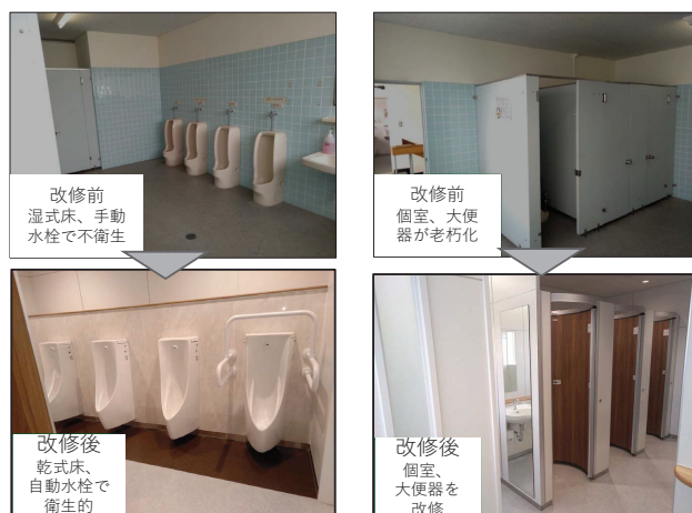
【トイレの改修により、誰もが使いやすい避難所として学校施設を活用(秋田県秋田市)】
