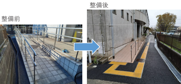
学校法人増田学園 千葉女子専門学校 「千葉女子専門学校避難経路設置工事」
