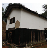
鉄骨補強、耐圧板設置
