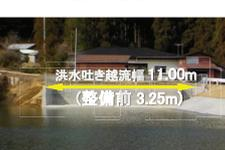
洪水吐き越流幅: 3.25m ⇒ 11.00m
