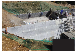
残存型枠を用いた砂防堰堤施工
