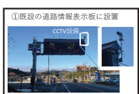
整備したCCTVカメラ (国道210号(大分県日田市天瀬町大字新地先))
