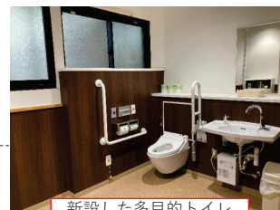
新設した多目的トイレ
