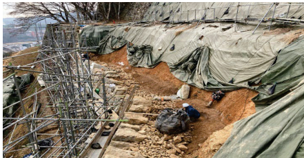
老朽化対策工事
