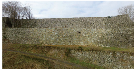
老朽化対策工事完了
