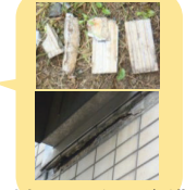
老朽化によりタイルが剥落
