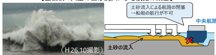
台風通過時の西防波堤付近における波浪状況
