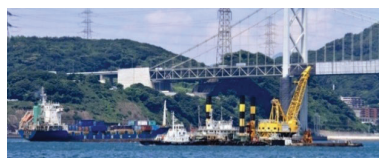
浚渫工事(関門航路)
