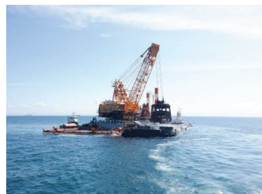
浚渫工事(宇部港)
