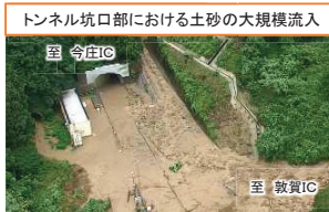
E8北陸自動車道(令和4年8月の大雨)
