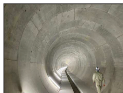
雨水貯留管内部 (仕上がり内径φ5,250mm)
