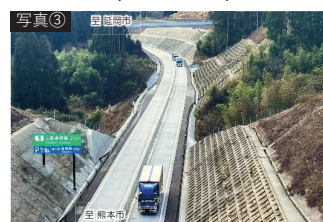
▲写真③ 山都中島西IC～山都通潤橋IC開通後の状況（R6.2）
