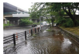
【対策前】 令和3年5月冠水
