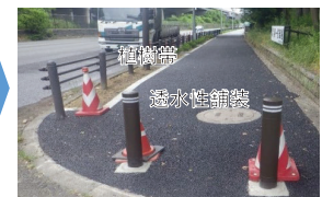
【対策後】 雨水貯留浸透機能の確保
