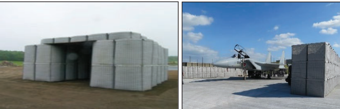
【簡易防護壁(箱型土のう)】
