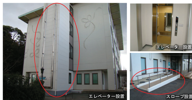
エレベーター設置
