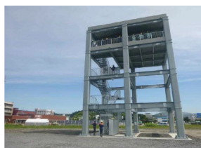
津波避難タワー
