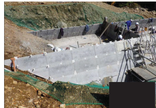
残存型枠を用いた砂防堰堤施工
