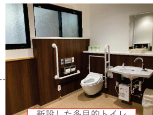
新設した多目的トイレ
