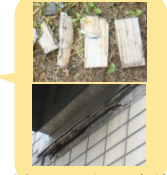
老朽化によりタイルが剥落
