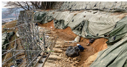
老朽化対策工事
