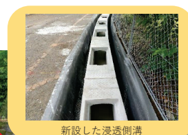
新設した浸透側溝
