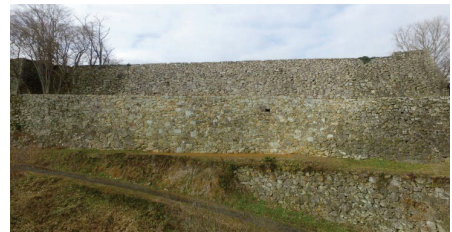
老朽化対策工事完了
