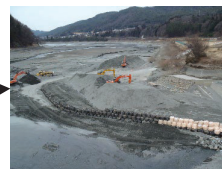
堆砂除去の様子（長野県 美和ダム）
