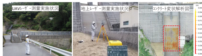
UAVレーザー測量実施状況
