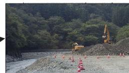
堆砂除去の様子（北海道 金山ダム）
