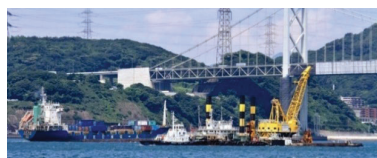
浚渫工事(関門航路)
