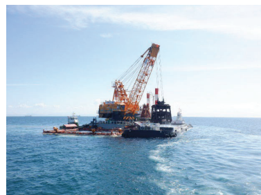
浚渫工事(宇部港)
