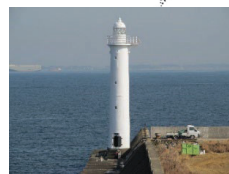
①四日市港防波堤灯台
