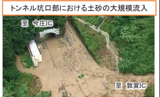
E8北陸自動車道(令和4年8月の大雨)
