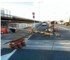
信号柱の倒壊
