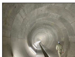
雨水貯留管内部 (仕上がり内径φ5,250mm)
