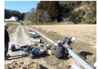
浄水場から配水池へ向かう水道管の破損・露出（輪島市） 下水を集約し処理場へ送る圧送管の被災現場（珠洲市）
