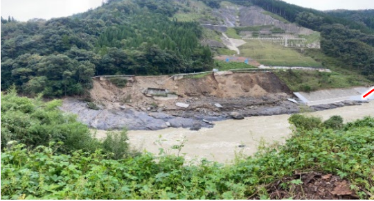
二級河川耳川被災状況（美郷町）
