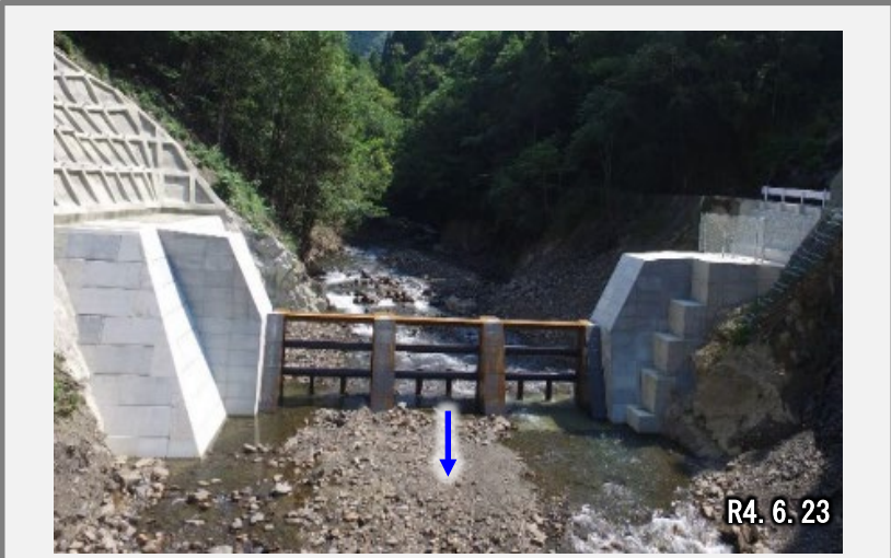
竹之元砂防堰堤(西米良村) 土石流捕捉量：約 5,000 m 3 (推定)
