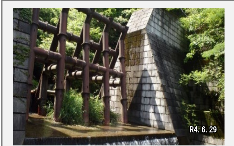
ずり口谷川砂防堰堤(椎葉村) 土石流捕捉量：約 3,500 m 3 (推定)
