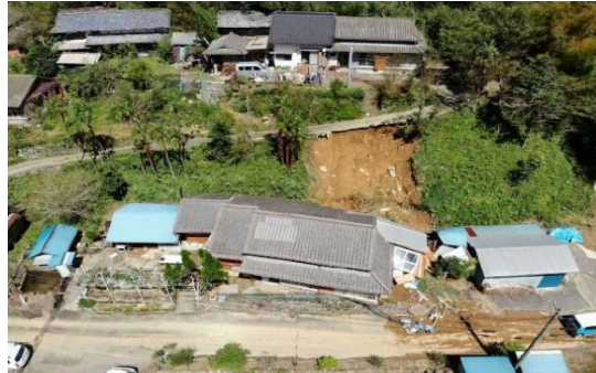
下渡川地区がけ崩れ状況（日向市）
