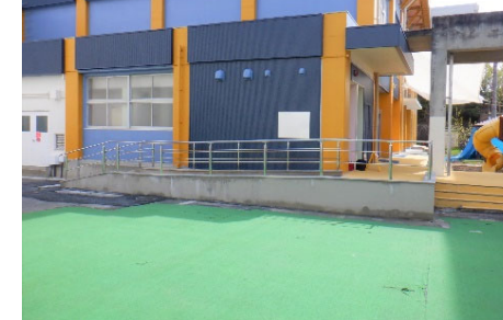
スロープの設置
