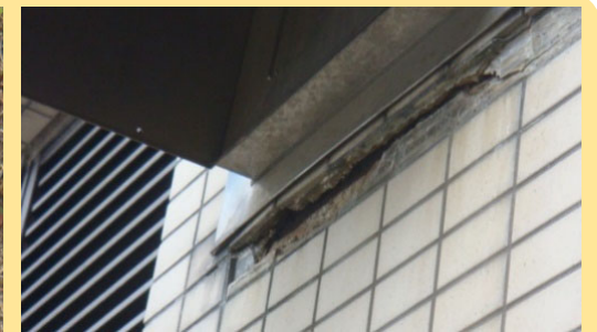
老朽化によりタイルが剥落
