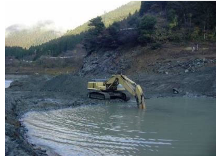
堆砂掘削による土砂等の撤去
