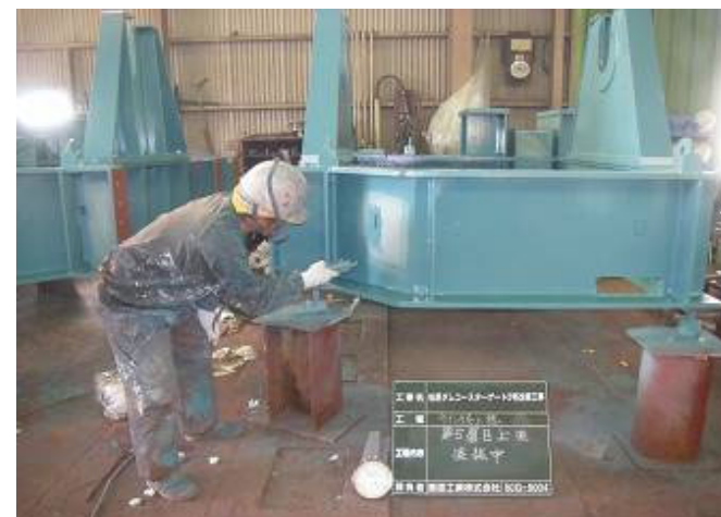
塗装による機械設備の補修
