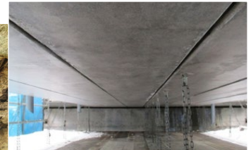
床版打ち換え
