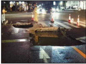
下水道に起因した道路陥没
