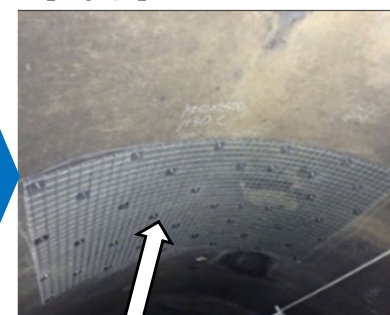
繊維シート貼付
