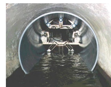
更生工法による老朽化対策
