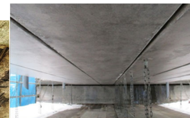
床版打ち換え
