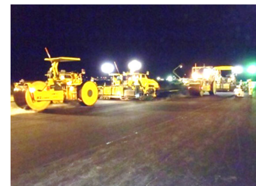
老朽化した滑走路舗装の改良
