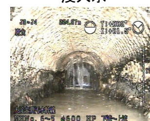
コンクリートが腐食し、鉄筋が露出した管路施設 管路の劣化の例
