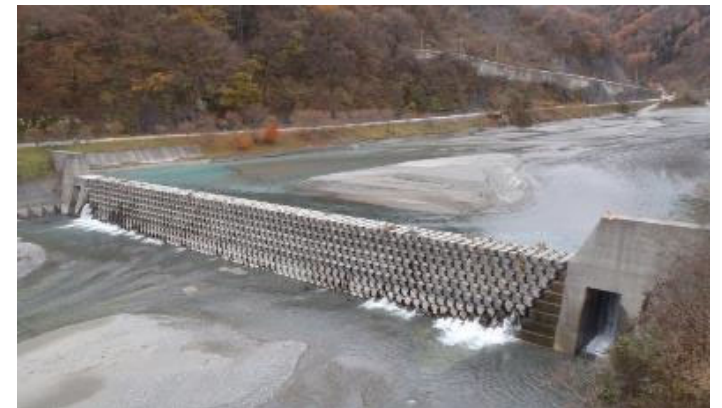
貯砂ダムによる土砂流入の低減
