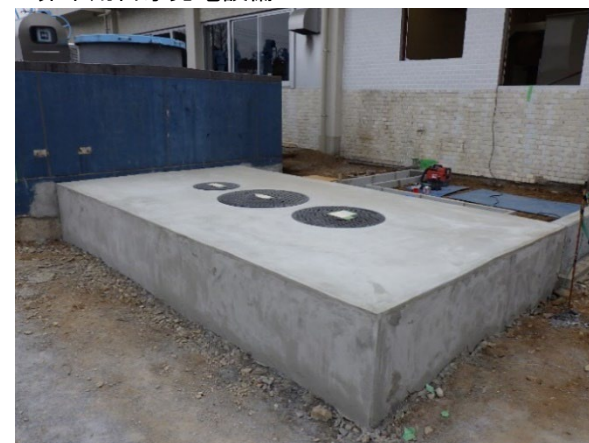
地下燃料タンク
