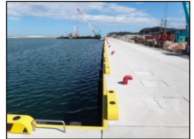
岸壁の耐震化による陸揚げ機能強化
