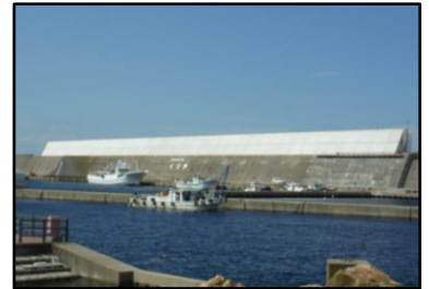
防波堤の嵩上げによる越波防止
