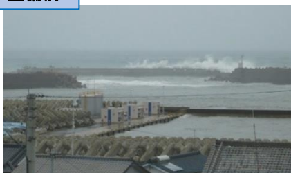
高波の進入や港内の攪乱状況
