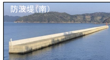
防波堤完成写真 ※防波堤(北)も同様
