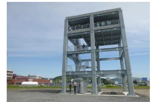
津波避難タワー
