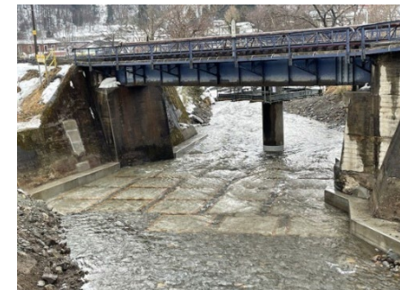
対策後(令和4年2月)
