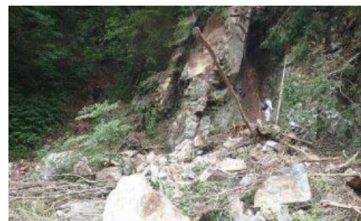
歩道法面の 崩落防止による 災害時の 避難経路の確保
