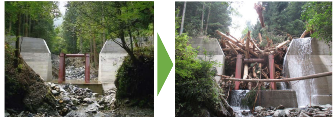
流木捕捉式治山ダムの整備による流木等の捕捉
