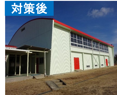
<鉄骨耐震ブレースの設置による耐震補強①>
