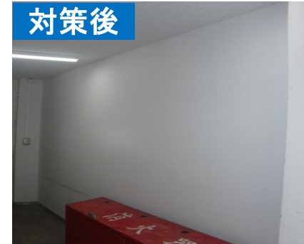
＜鉄筋コンクリート造の耐力壁に改修＞
