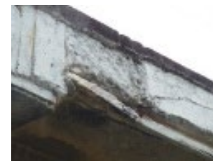
外壁、柱のひび割れ状況の例
