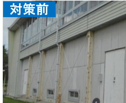
<鉄骨耐震ブレースの設置による耐震補強②>
