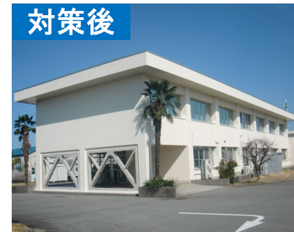
＜鉄骨耐震ブレースの設置による耐震補強＞
