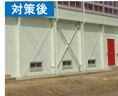
<鉄骨耐震ブレースの設置による耐震補強②>
