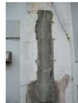
外壁、柱のひび割れ状況の例
