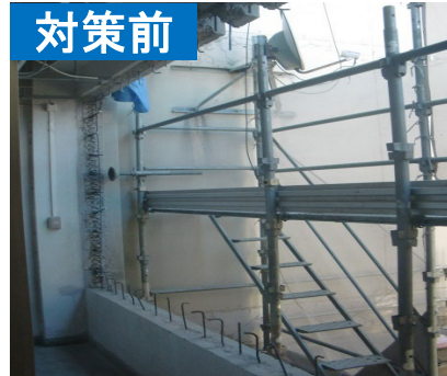
＜鉄筋コンクリート造の耐力壁に改修＞
