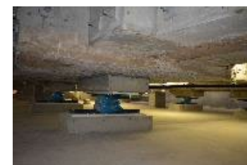
免震装置設置
