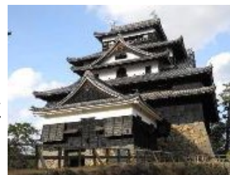
耐震補強：松江城天守
