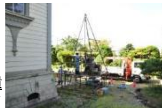
ボーリングによる地盤調査
